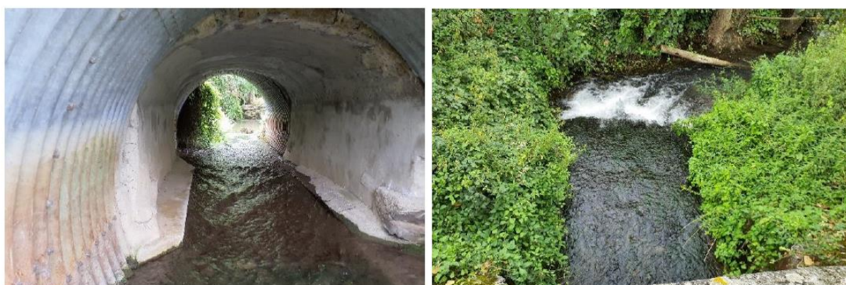
Figure 34. Buse métallique et seuil en aval de la D120 (Source : Biotope)
